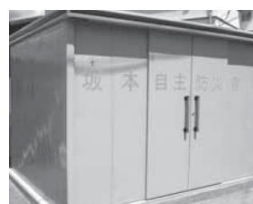
▲中区坂本の防災倉庫
