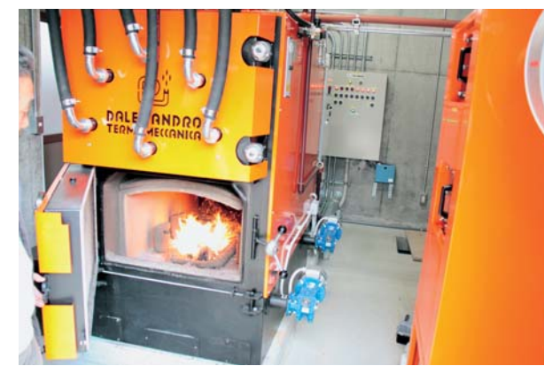
▲火の入った新しい木質チップボイラー
